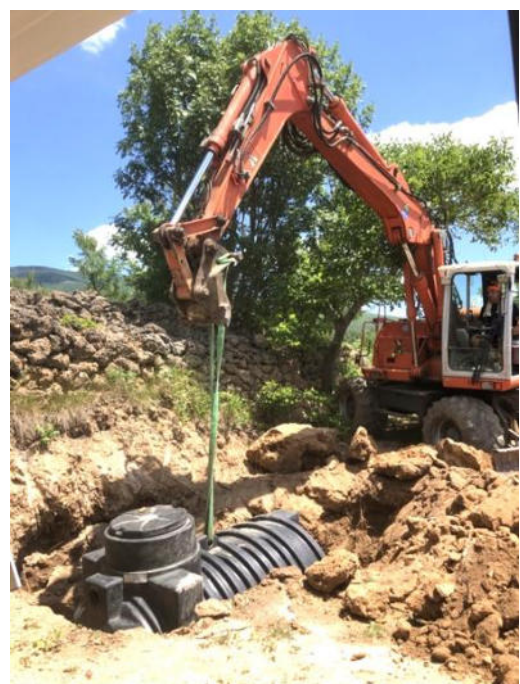
Die Arbeiten für das neue Tierheim in Knin laufen auf Hochtouren
